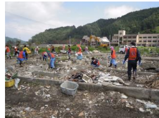
瓦礫撤去作業
