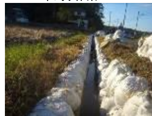
生活排水溝の泥出し・土壌積
